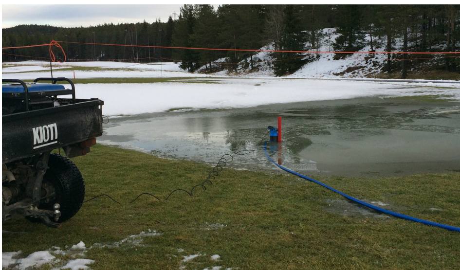
Leysingavatn getur orðið til vandræða á veturnum. Færanleg dæla getur nýst til að draga úr svellamyndum. Ljósmynd: Allan Ferm, Grønmo-golfvöllinum í Ósló 28. janúar 2016.
